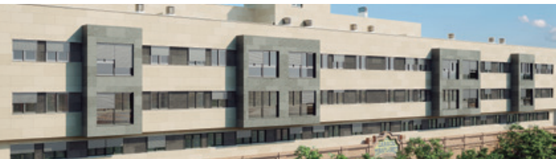
■ Edificio Miraflores (Sevilla)
