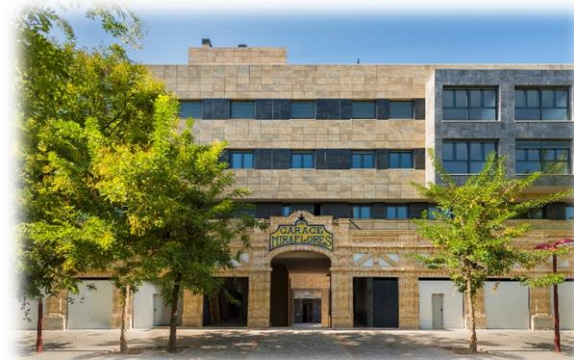
Edificio Miraflores (Sevilla)
